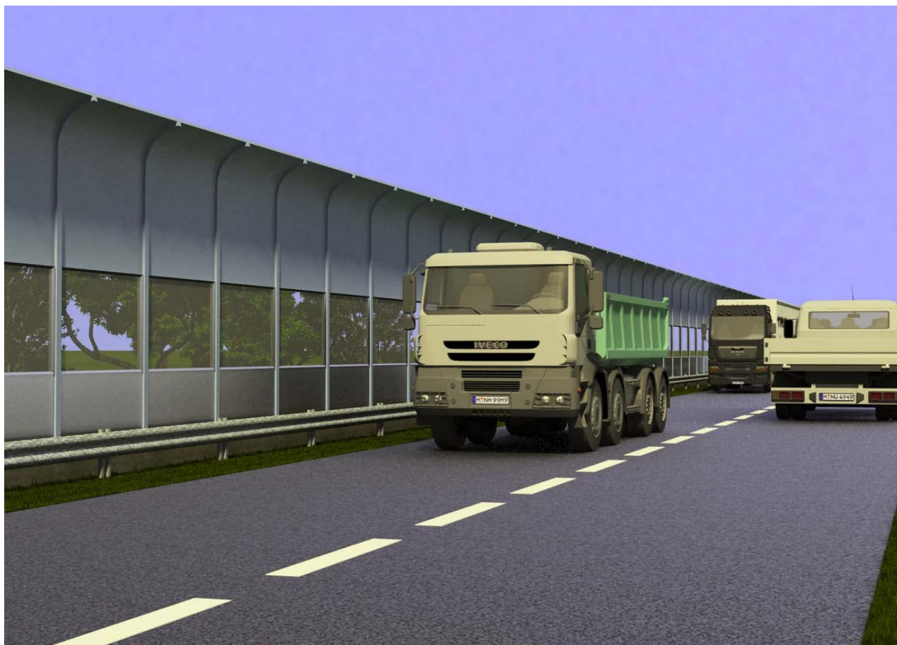
Фиг. 7.12 3-D визуализация от конкретен реализиран от СПЕКТРИ ЕООД проект за изграждане на противошумови бариери (предвидени като типово решение за описаните по-горе мерки с ИД № BC1, BC2, BC3, BC4, BC5, BC6, BC7, BSAR.
